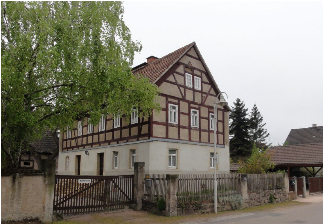
Historisches Wohngebäude im Überschwemmungsgebiet.
