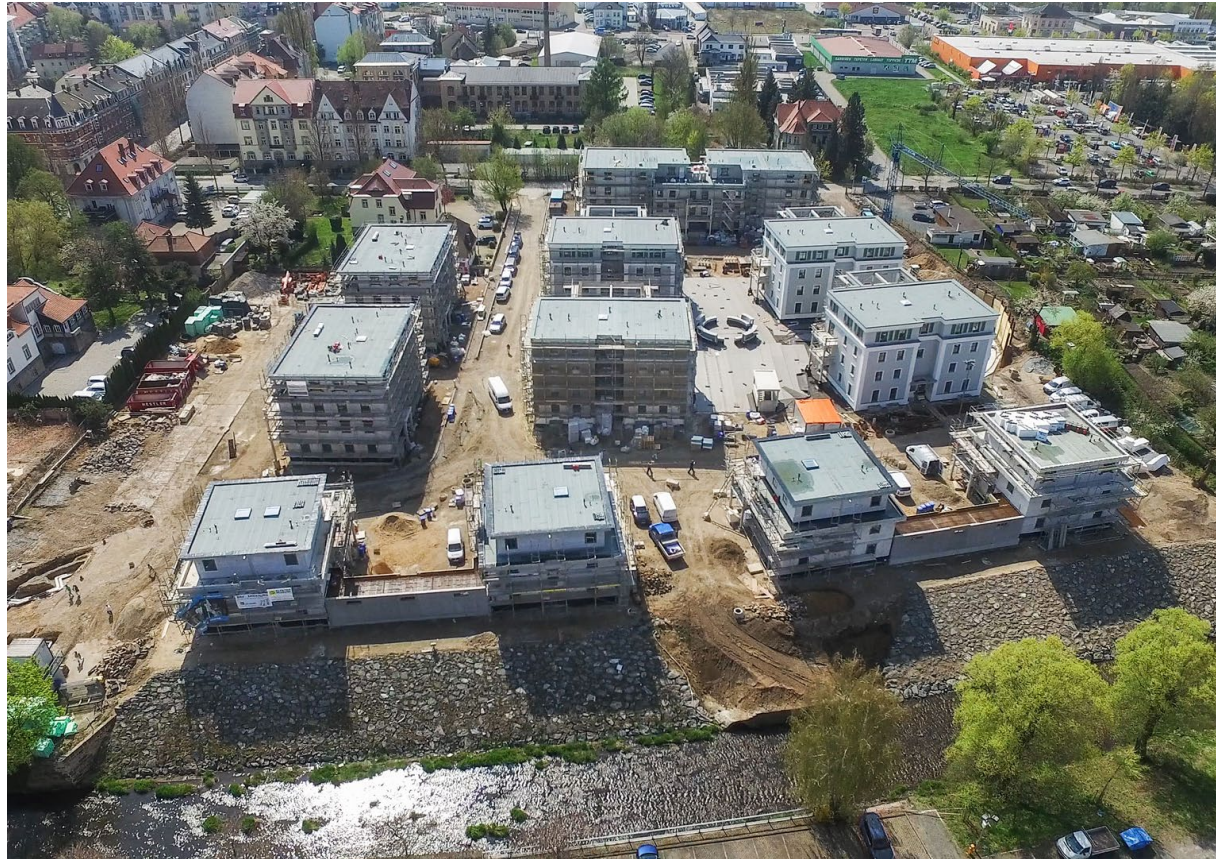
Neubau eines Wohnquartiers in Pirna
