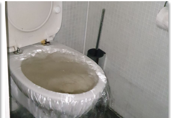
Kanalisationsrückstau
