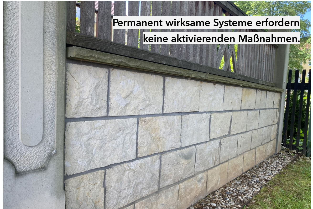
Erhöhung von Mauersockeln von Zaunanlagen
