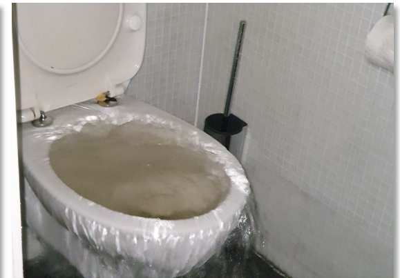
Kanalisationsrückstau
