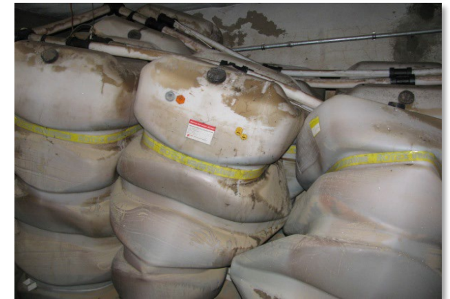
Schäden durch Kontamination
