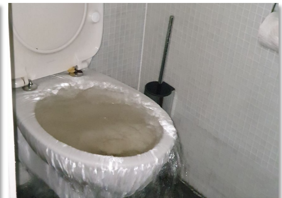
Kanalisationsrückstau
