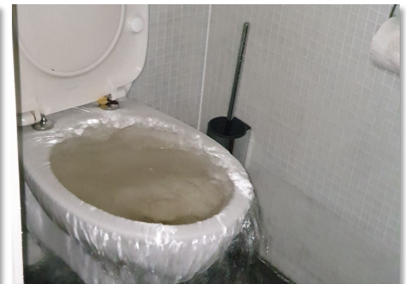
Kanalisationsrückstau
