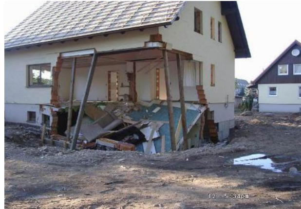
Strukturelle Schäden
