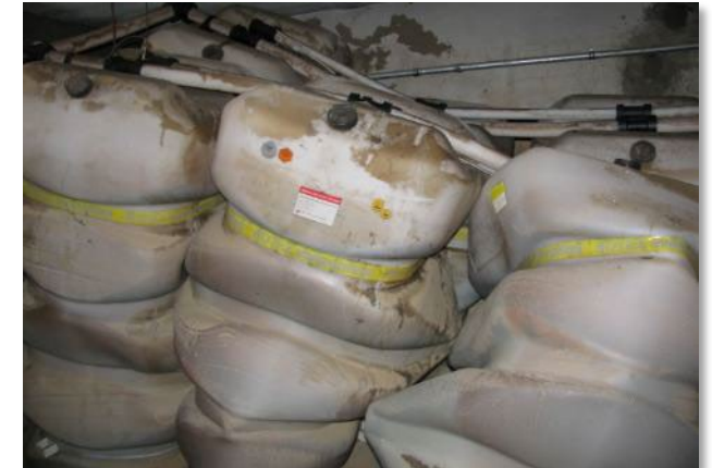
Schäden durch Kontamination
