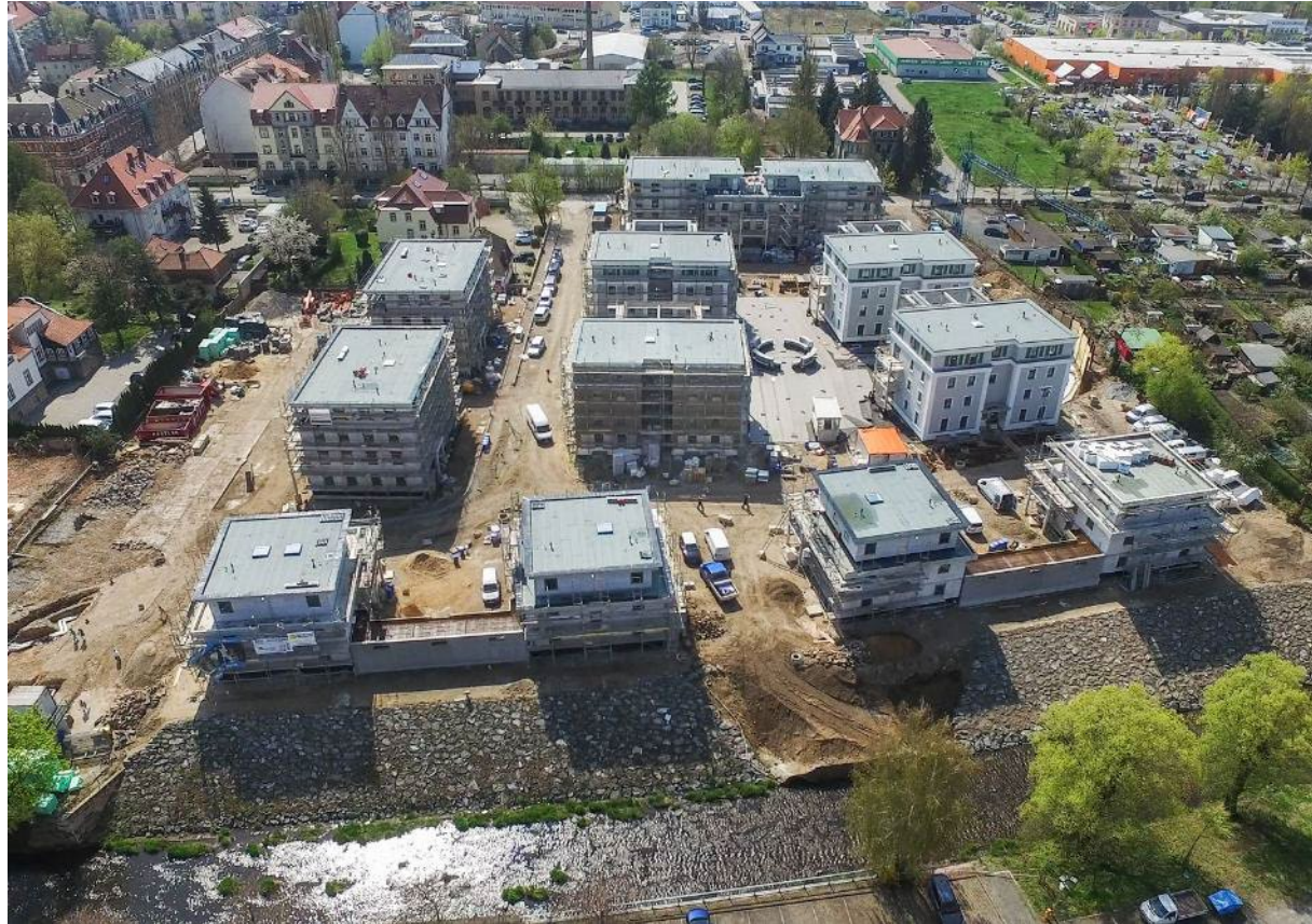
Neubau eines Wohnquartiers in Pirna
