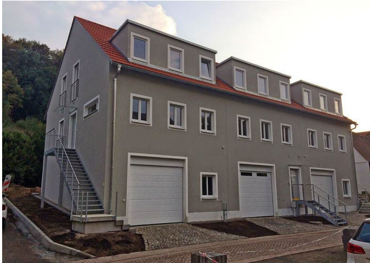
Neubau eines Reihenhauses in Pirna
