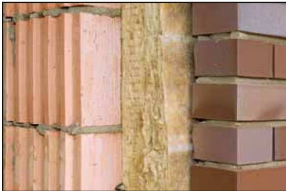
Abb. 5: Zweischaliges Mauerwerk mit Kerndämmung (Mineralwolle) (© HTW Dresden)
