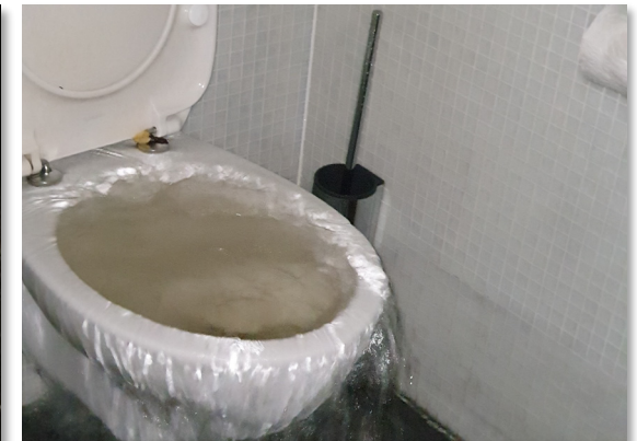
Kanalisationsrückstau
