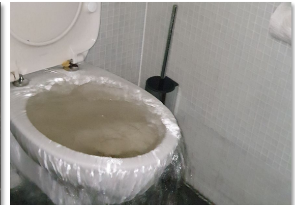
Kanalisationsrückstau
