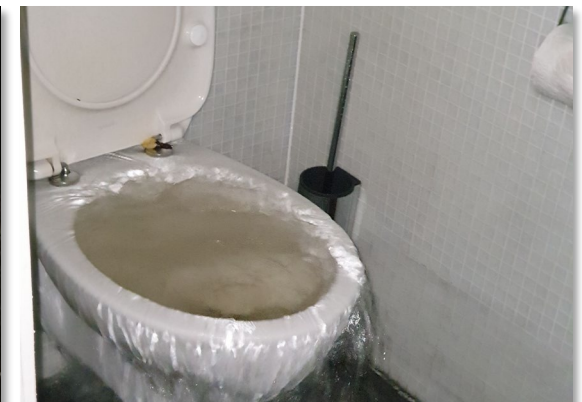
Kanalisationsrückstau
