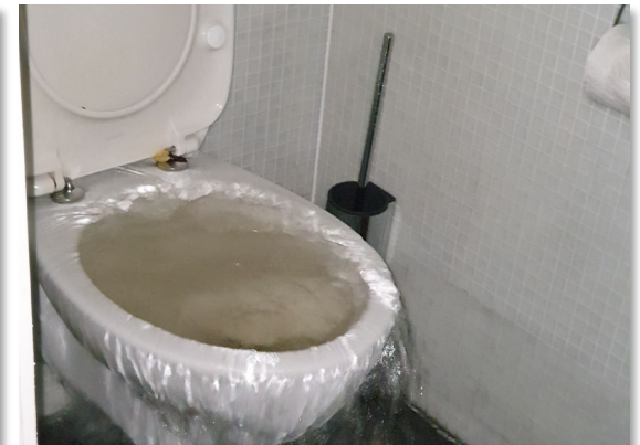
Kanalisationsrückstau
