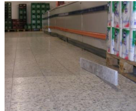
Quellverformung CA-Estrich
