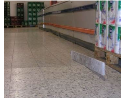
Quellverformung CA-Estrich
