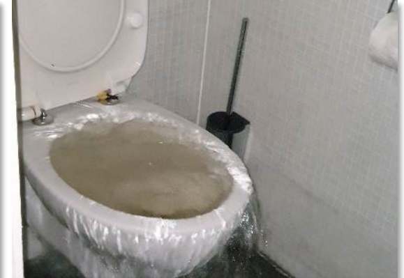
Kanalisationsrückstau
