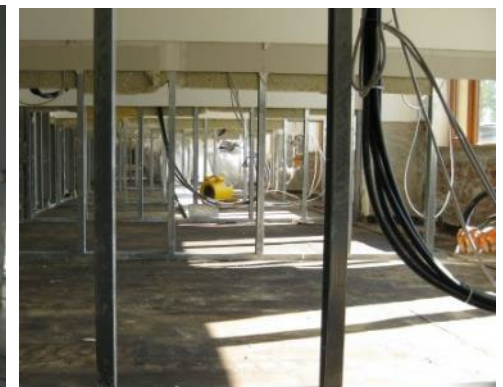
Rückbau leichter Trennwände
