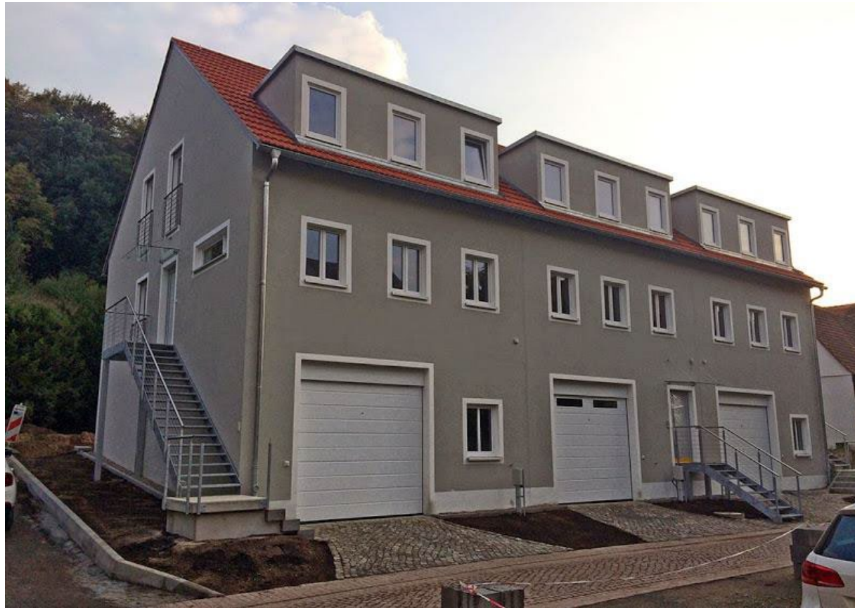
Neubau eines Reihenhauses in Pirna
