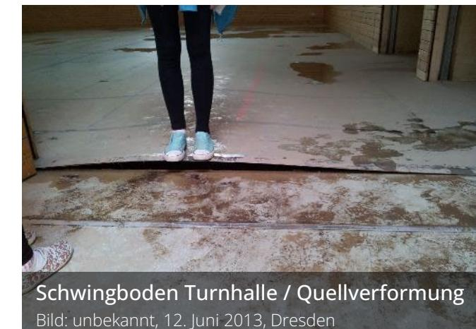
**Schwingboden Turnhalle / Quellverformung**
