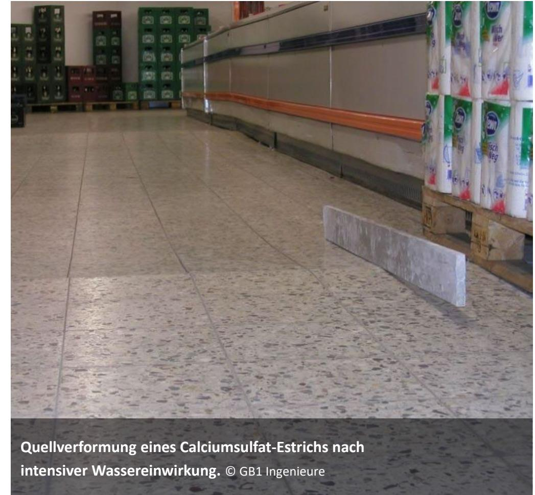
Quellverformung eines Calciumsulfat-Estrichs nach intensiver Wassereinwirkung. © GB1 Ingenieure
