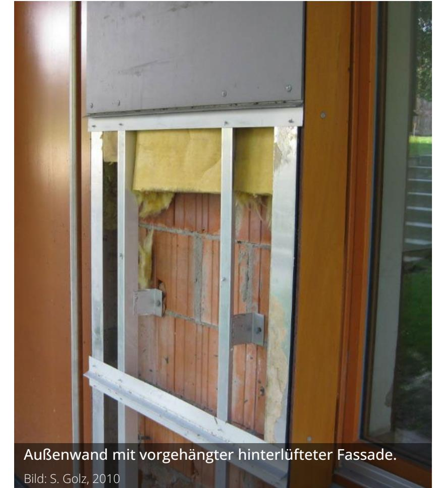
Außenwand mit vorgehängter hinterlüfteter Fassade.
