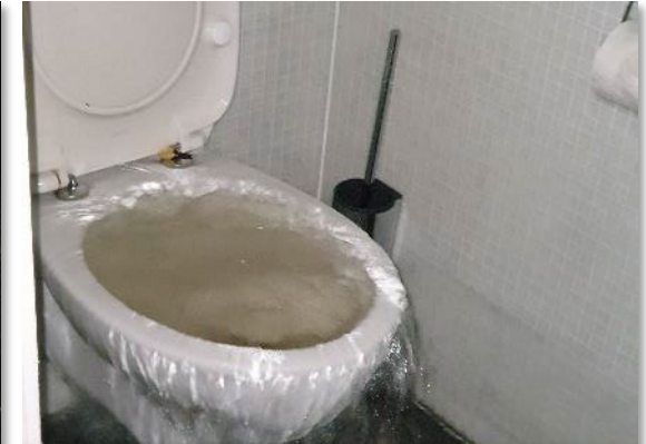
Kanalisationsrückstau
