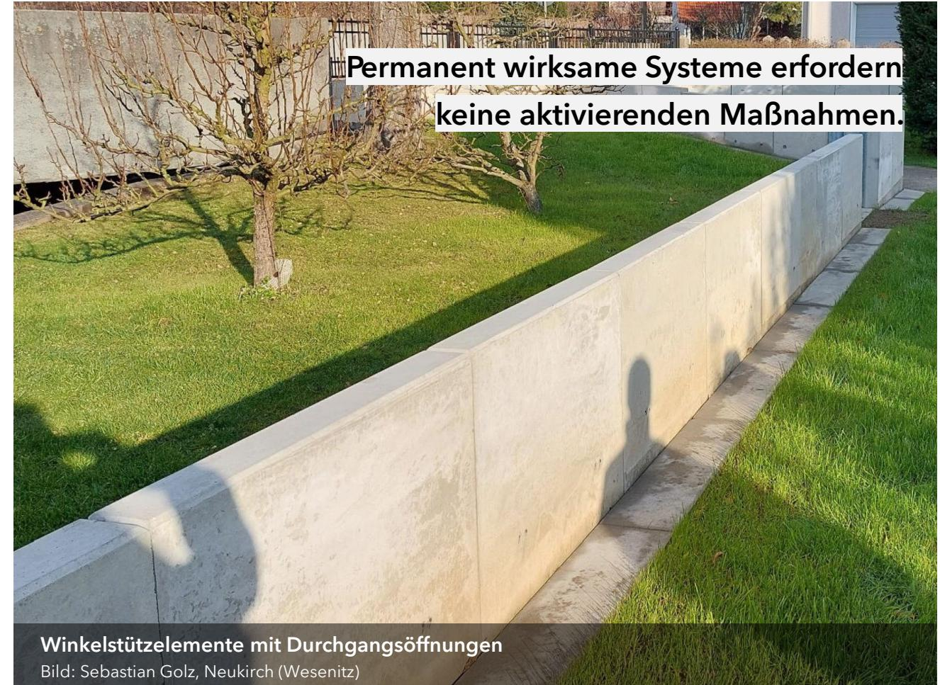
**Winkelstützelemente mit Durchgangsöffnungen**
