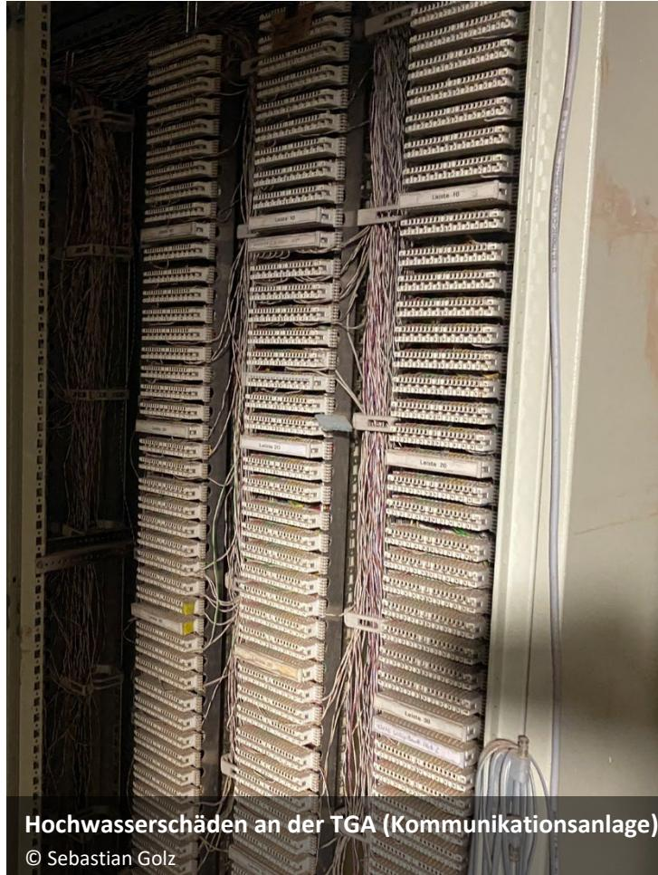
Hochwasserschäden an der TGA (Kommunikationsanlage)
