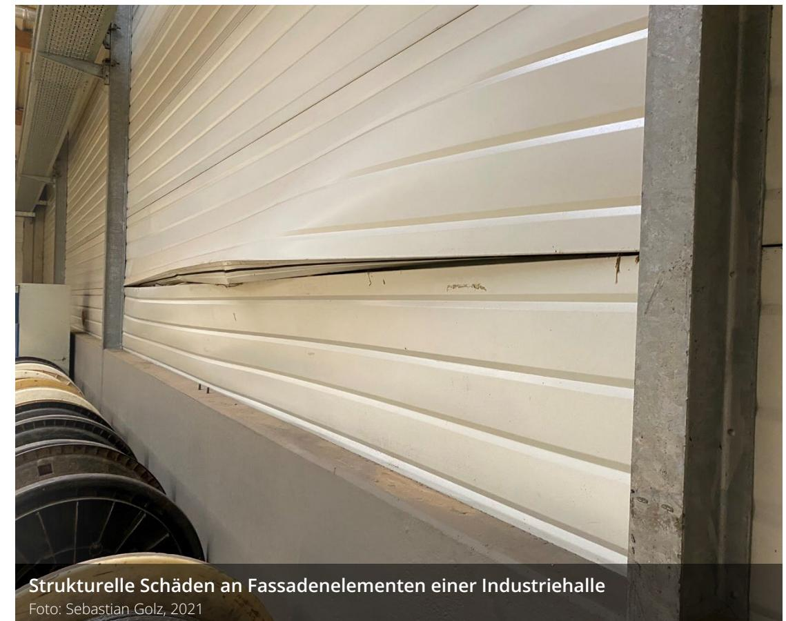
Strukturelle Schäden an Fassadenelementen einer Industriehalle
